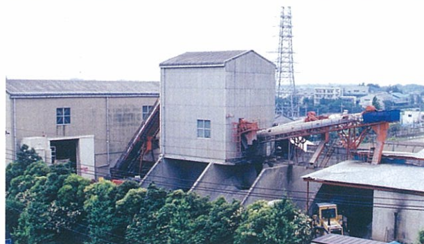
建設発生土・廃コン・廃アスコンのリサイクルプラント
