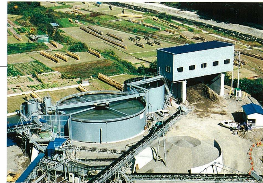
濁水処理装置 タイヤスロンシクナー フィルタープレス
