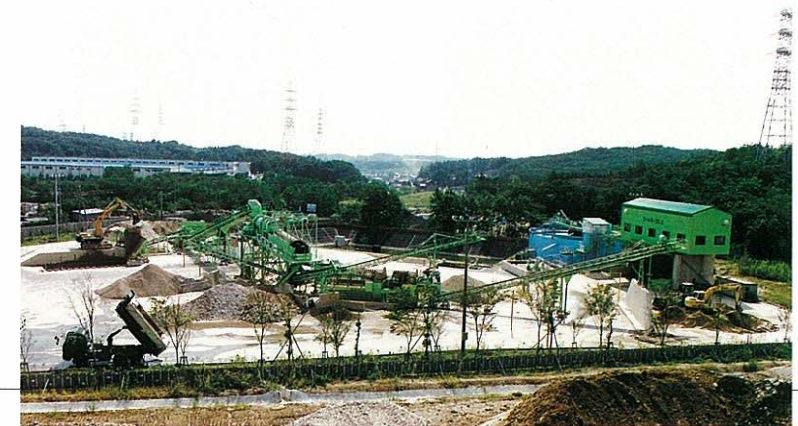
建設汚泥・残土リサイクルプラント
