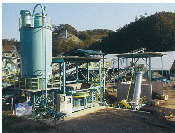
〔ダム現場で稼働中のケークルⅡ50型〕
