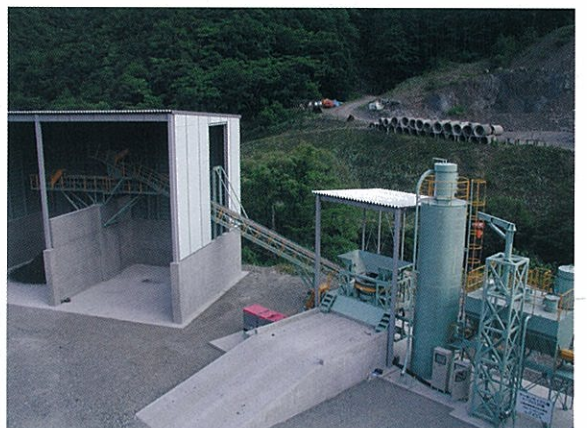
[砕石工場稼働中のケーキルⅡ30型]
