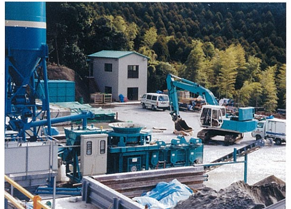
[建設汚泥処理工場稼働中のケーキルⅡジュニア型]
